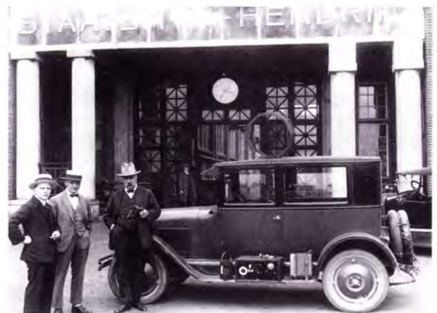
V.l.n.r. de heren Begas, Van Deth en Corver bij de ingang van Staatsmijn Hendrik; op de treeplank van de auto de ontvanger en op het dak de raamantenne (Foto: collectie fam. Begas).
